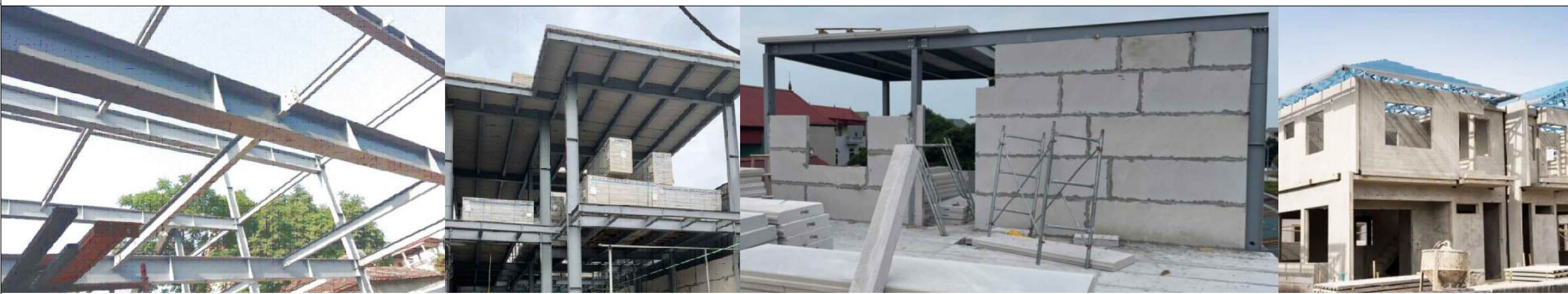
CÁC HÌNH ẢNH THI CÔNG THỰC TẾ
