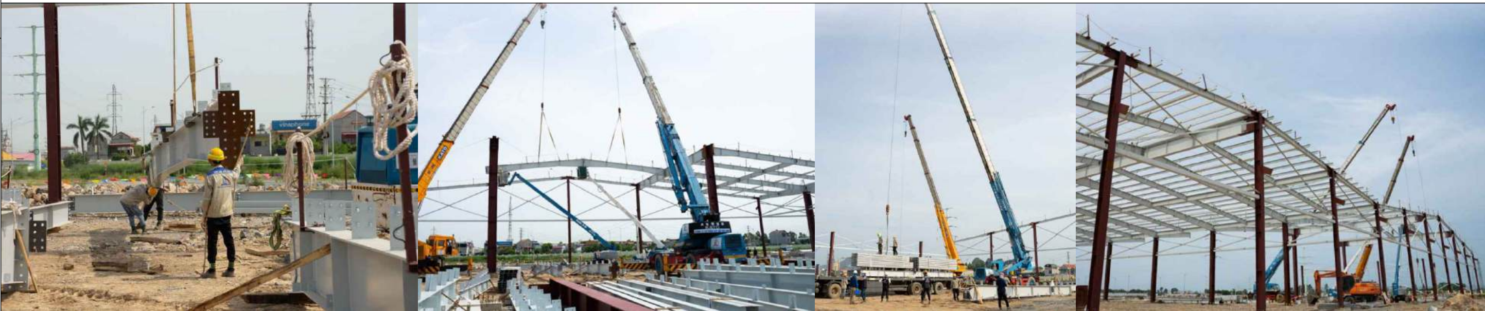
CÁC HÌNH ẢNH THI CÔNG THỰC TẾ
