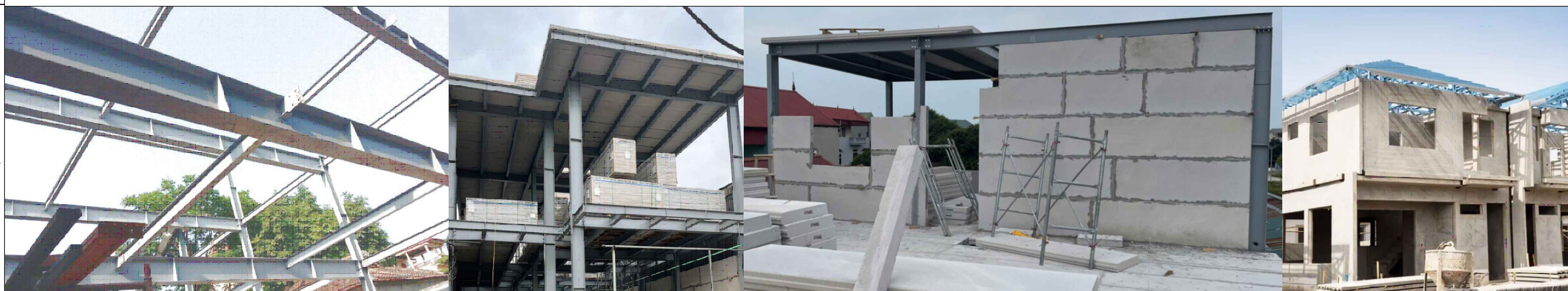
CÁC HÌNH ẢNH THI CÔNG THỰC TẾ
