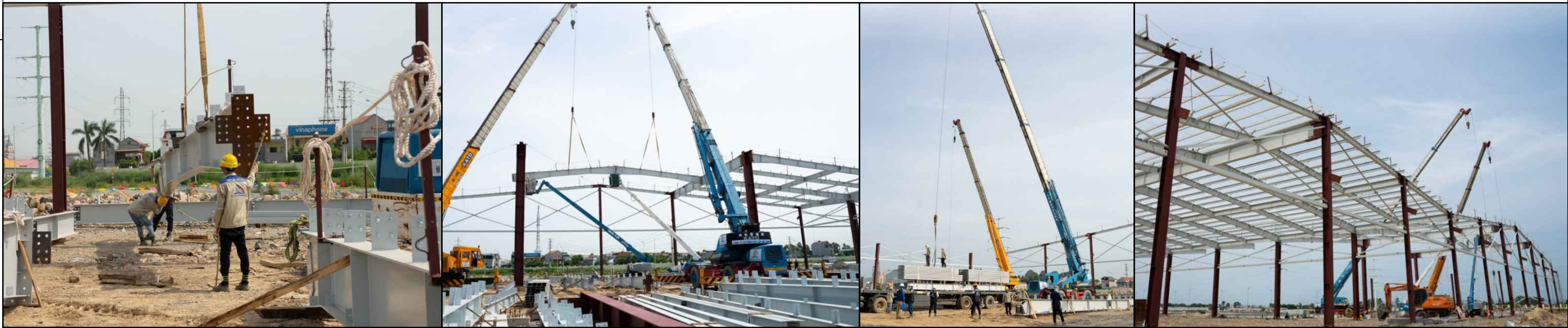
CÁC HÌNH ẢNH THI CÔNG THỰC TẾ
