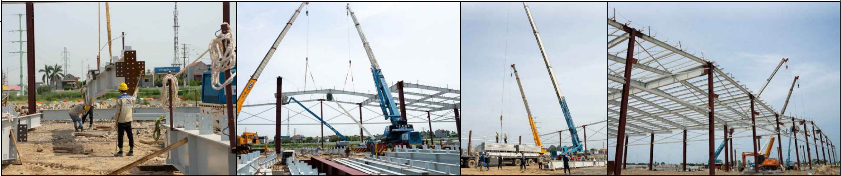
CÁC HÌNH ẢNH THI CÔNG THỰC TẾ
