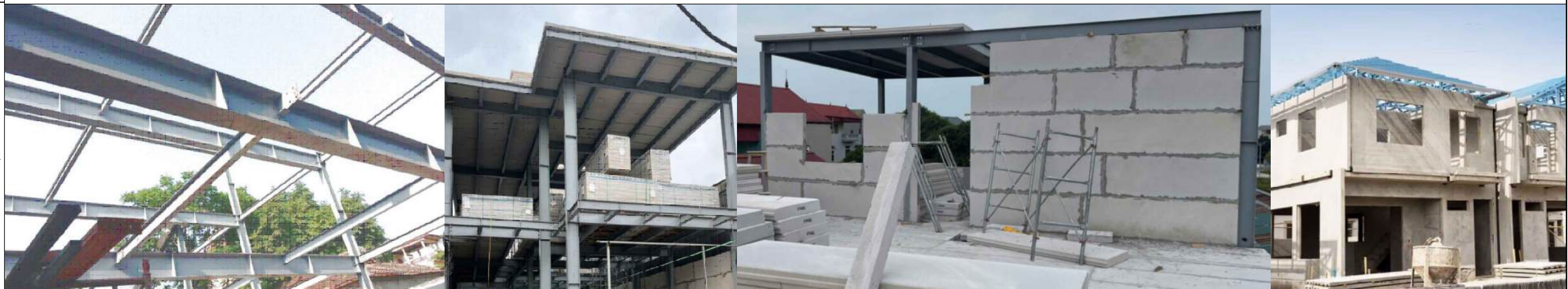
CÁC HÌNH ẢNH THI CÔNG THỰC TẾ
