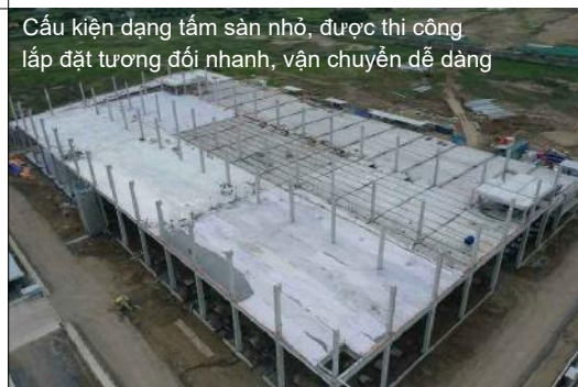
Thi công lắp ghép nhà thấp tầng theo kiểu tấm nhỏ, không cột, tường chịu lực
