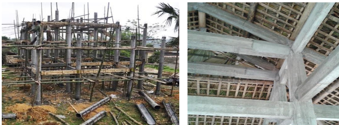
Hình 3.16: Nhà sàn xây cột bê tông, xà liên trực tiếp ngày càng phổ biến. (Ng: Internet)
