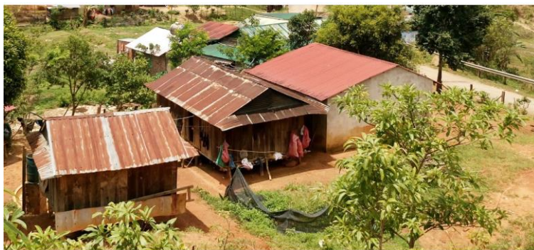
Hình 3.14: Xu hướng xây dựng thêm nhà phụ làm bếp, khu vệ sinh kề sát nhà sàn với vật liệu tôn đơn giản tại xã Tê Xăng (Ng: Internet)
