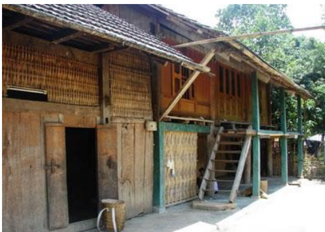
Hình 3.17: Xu hướng chuyển từ sử dụng mái lợp rơm, tranh sang mái lợp ngói, tôn hoặc fibrô-ximăng, cột bê tông... (Ng: Internet)
