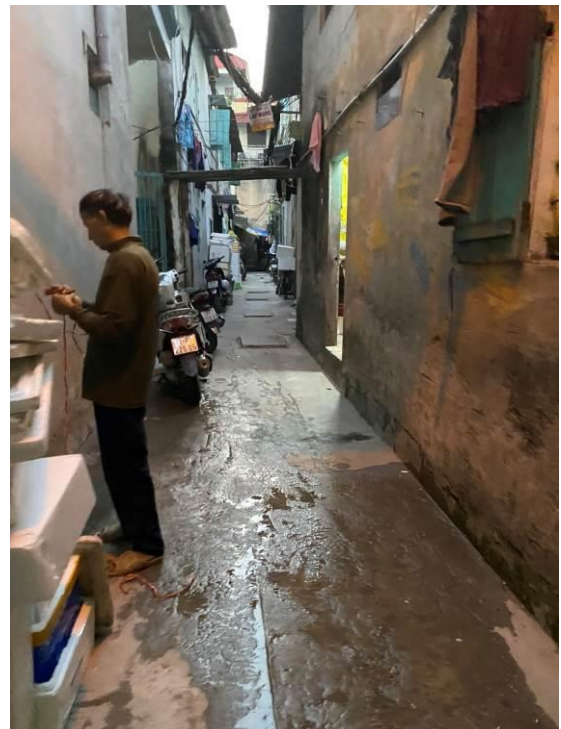
Hình 3.27d: Cống thoát nước nằm giữa ngõ và được đậy bằng các nắp đan
