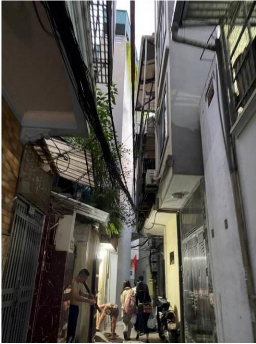
Hình 3.26a: Xây dựng lấn chiếm không gian phía trên ngõ
