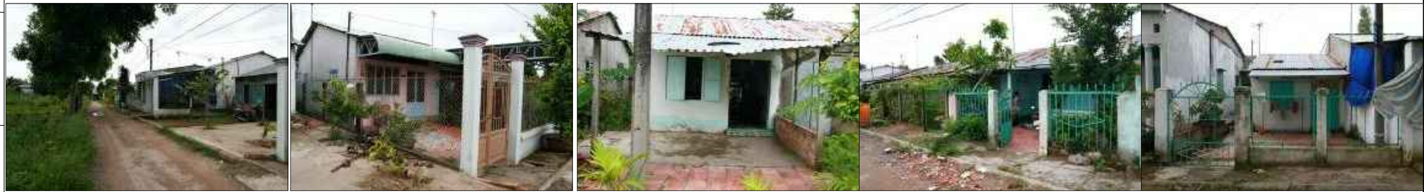
NHÀ Ở CỤM TUYẾN DÂN CƯ VƯỢT LŨ XÃ MỸ KHÁNH - HUYỆN PHONG ĐIỂN - TỈNH CẦN THƠ
