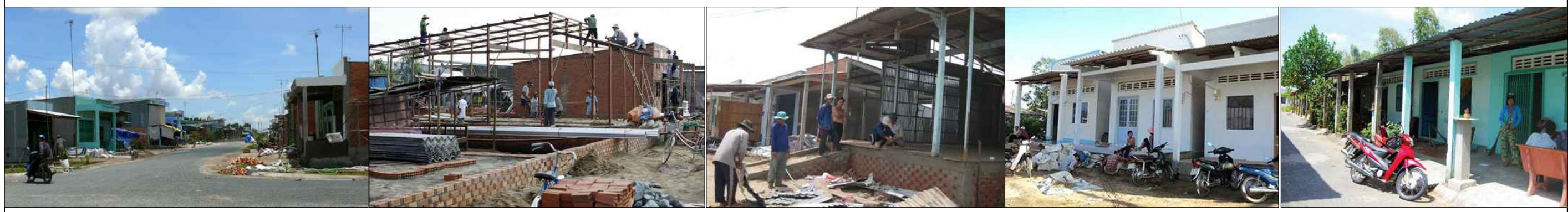
NHÀ Ở CỤM TUYẾN DÂN CƯ VƯỢT LŨ XÃ BÌNH THỦY - HUYỆN CHÂU PHÚ - TỈNH AN GIANG
