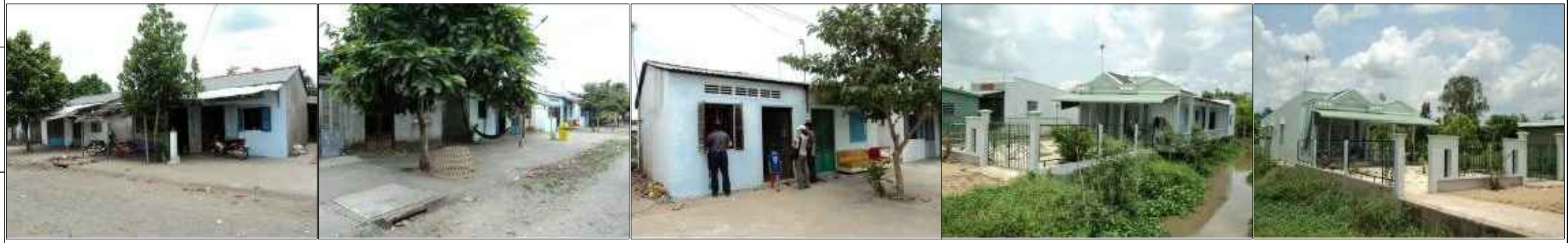
NHÀ Ở CỤM TUYẾN DÂN CƯ VƯỢT LŨ XÃ TRƯỜNG LONG - HUYỆN PHONG ĐIỂN - TỈNH CẦN THƠ
